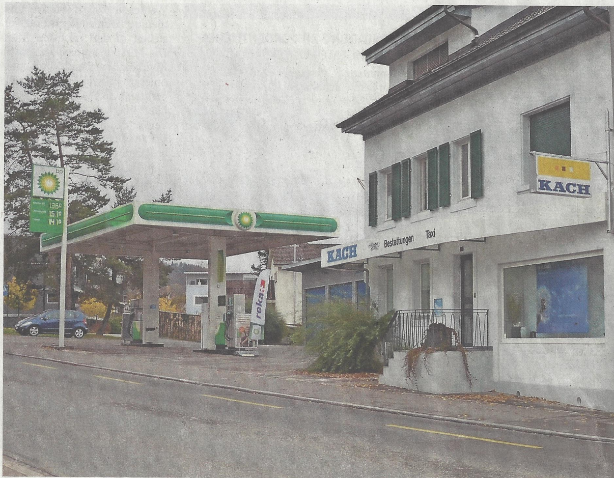
Vertrag bereits vereinbart: Der Gemeinderat will das 2000 Quadratmeter grosse Firmenareal von Käch Bestattungen mit- samt Tankstelle kaufen, um es bei der SuSI-Planung miteinbeziehen zu können.
